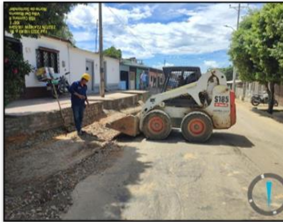
CORTE Y DEMOLICION DE PAVIMENTO, EXCAVACION CON MAQUINA
