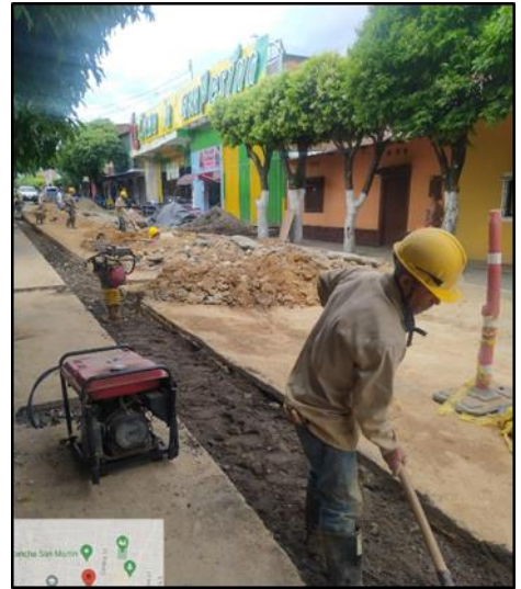
Reposición de tubería de acueducto, relleno y compactación de material (base- subbase)
