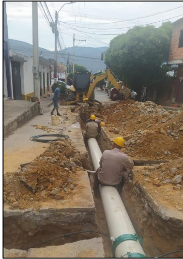
Excavacion mecanica y reposicion de tuberia de acueducto
