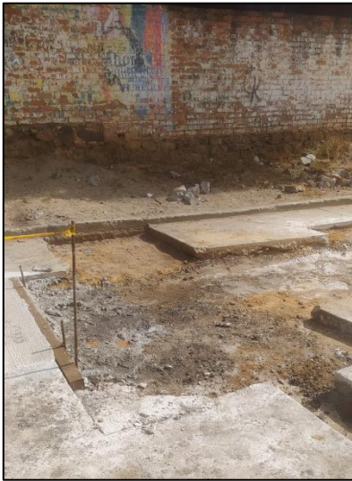
Cortes de sobrecanchos y compactacion de material (base- subbase)
