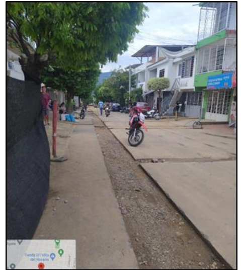
Cortes de sobrecanchos y compactacion de material (base- subbase)
