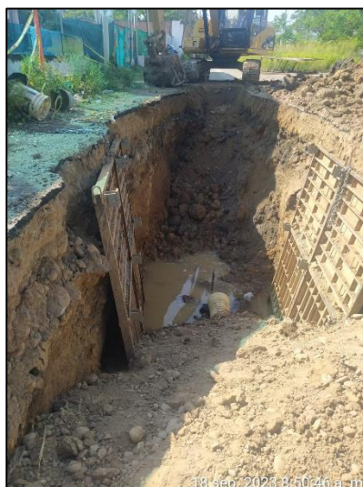
Instalación de formaletas de contención y construcción de pozos de inspección
