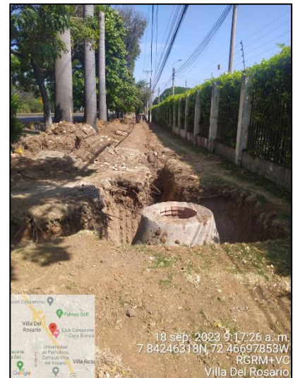
Instalación de formaletas de contención y construcción de pozos de inspección
