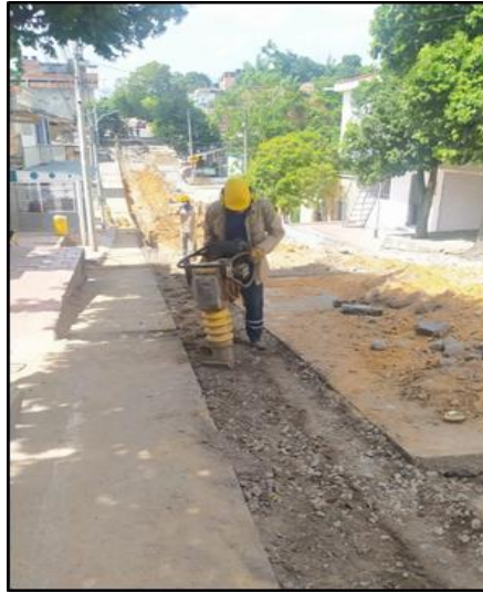
Reposición de tubería de acueducto, relleno y compactación de material (base- subbase)
