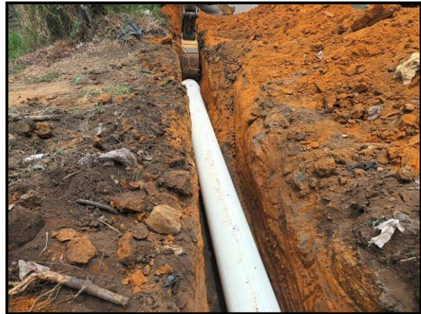
Imagen 21 Actividades relevantes del proyecto en ejecución "Construcción nueva línea de aducción de \varnothing 14" PVC presión desde captación hasta la PTAP"
