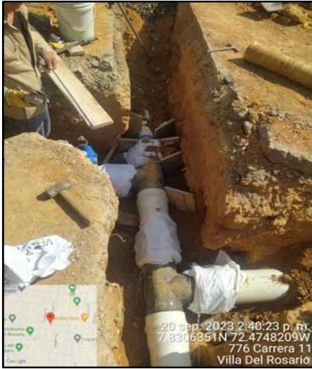
Reposición de tubería de acueducto, relleno y compactación de material (base- subbase)
