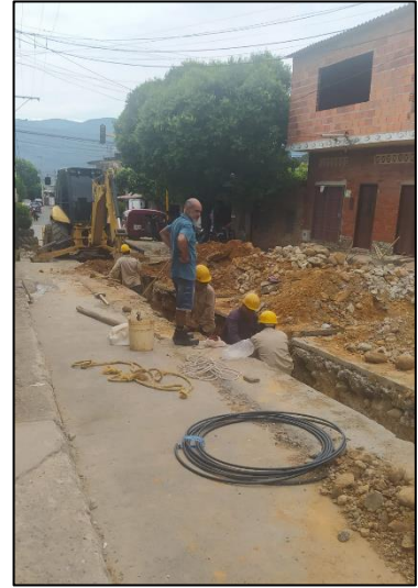
Excavacion mecanica y reposicion de tuberia de acueducto
