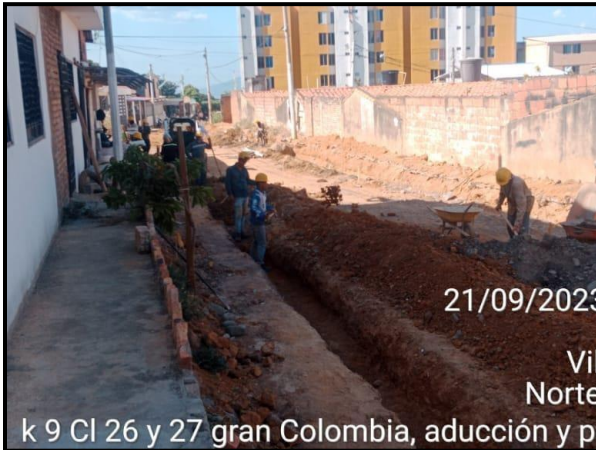
Imagen 21 Actividades relevantes del proyecto en ejecución "Construcción nueva línea de aducción de \varnothing 14" PVC presión desde captación hasta la PTAP"
