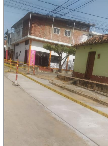
Recubrimiento de tubería en la calle 8 entre carr 8 y 9; pavimento en asfalto y concreto
