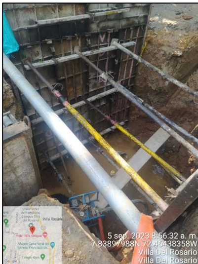
Instalación de formaletas de contención y construcción de pozos de inspección
