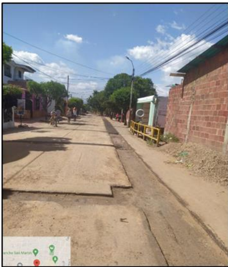
Reposición de tubería de acueducto, relleno y compactación de material (base- subbase)
