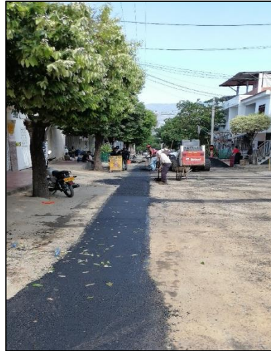
Recubrimiento de tubería en la calle 8 entre carr 8 y 9; pavimento en asfalto y concreto
