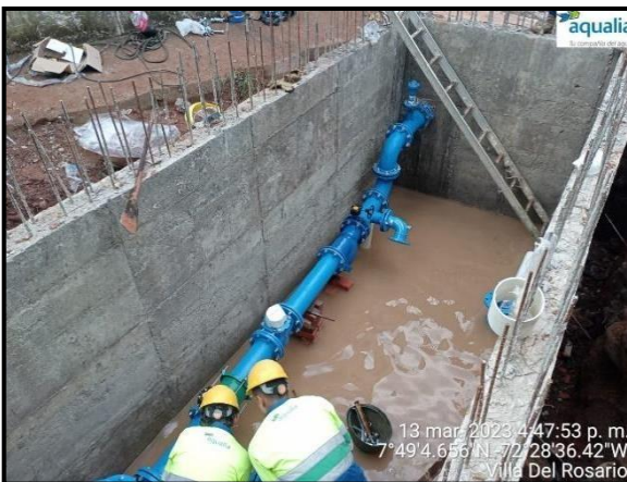
Imagen 20 Actividades relevantes ejecutadas en el proyecto "Construcción de dos (2) arquetas en concreto reforzado para la instalación de macromedición en la red de distribución de agua potable en las salidas del tanque australiano en la PTAP del municipio de Villa del Rosario"
