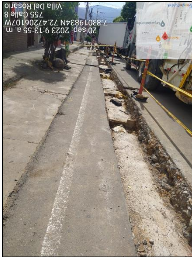
Recubrimiento de tubería en la calle 8 entre carr 8 y 9; pavimento en asfalto y concreto
