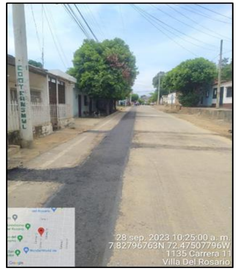
Reposición de tubería de acueducto, relleno y compactación de material (base- subbase)
