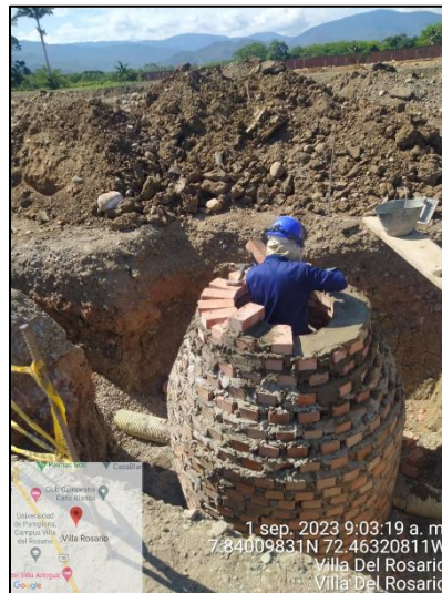
Instalación de formaletas de contención y construcción de pozos de inspección
