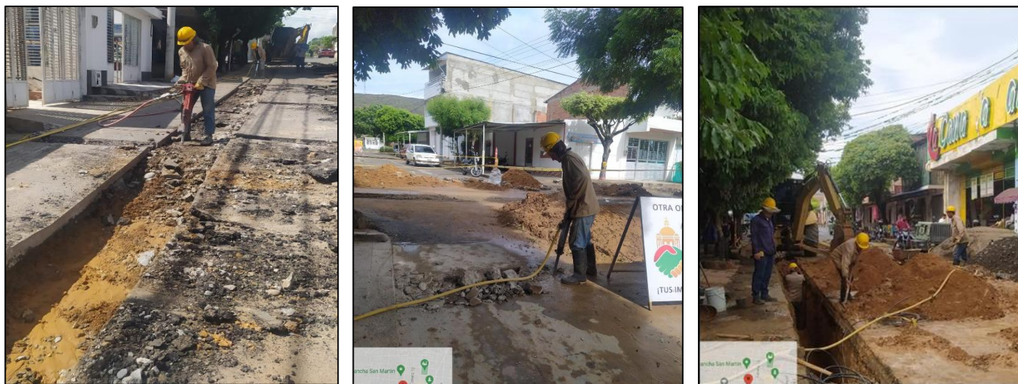
Corte, demolición de pavimento y excavación con maquina
