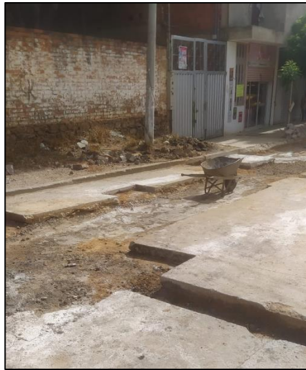
Cortes de sobrecanchos y compactacion de material (base- subbase)
