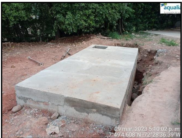
Imagen 20 Actividades relevantes ejecutadas en el proyecto "Construcción de dos (2) arquetas en concreto reforzado para la instalación de macromedición en la red de distribución de agua potable en las salidas del tanque australiano en la PTAP del municipio de Villa del Rosario"
