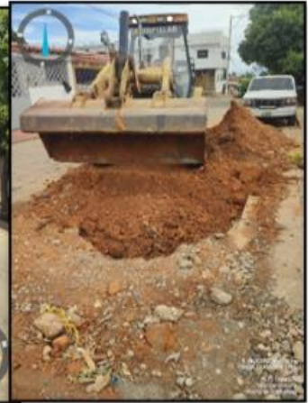
CORTE Y DEMOLICION DE PAVIMENTO, EXCAVACION CON MAQUINA
