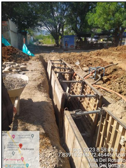
Instalación de formaletas de contención y construcción de pozos de inspección
