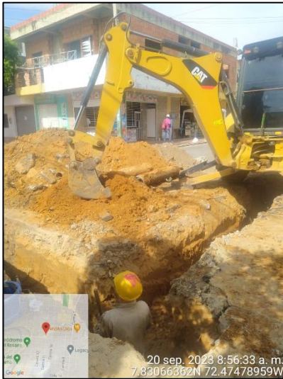
Excavacion mecanica y reposicion de tuberia de acueducto
